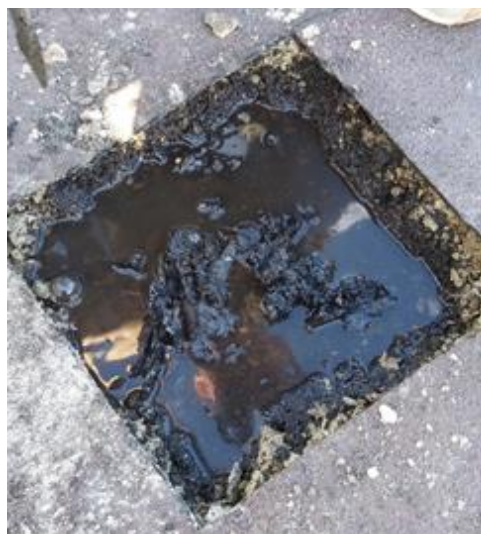
Рис. 4. Замачивание утеплителя
