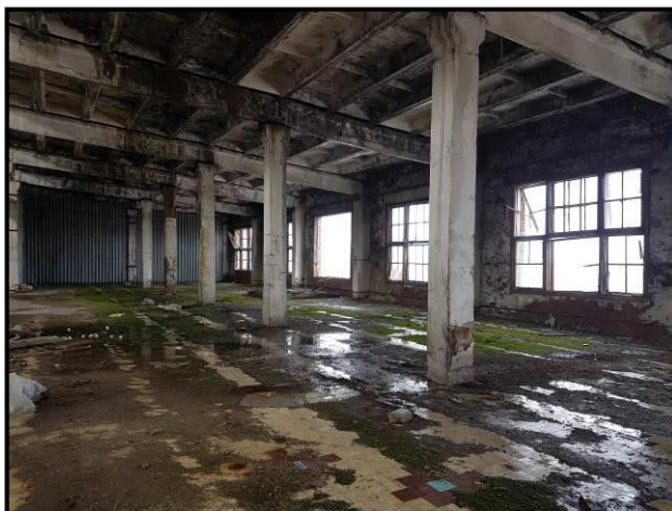
Рис. 2. Общее состояние конструкций покрытия 4 этаж
