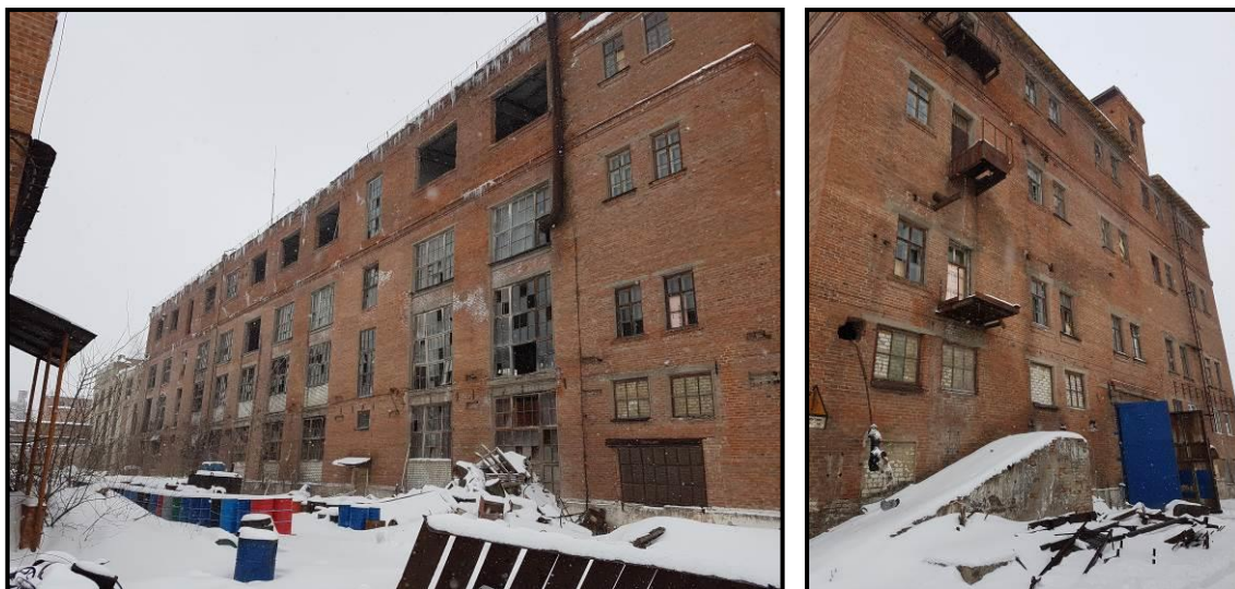
Рис. 1. Здание цеха ВЖС Шебекинского химического завода
