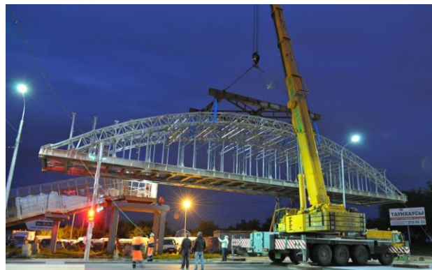
Фото 8. Монтаж пешеходного моста, 2017 год
